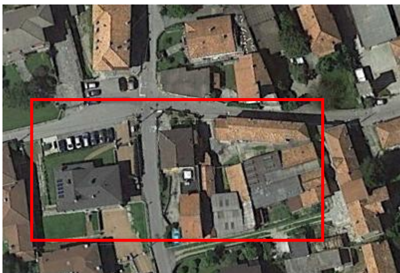
Visione di insieme degli interventi D 19/22/23/24
